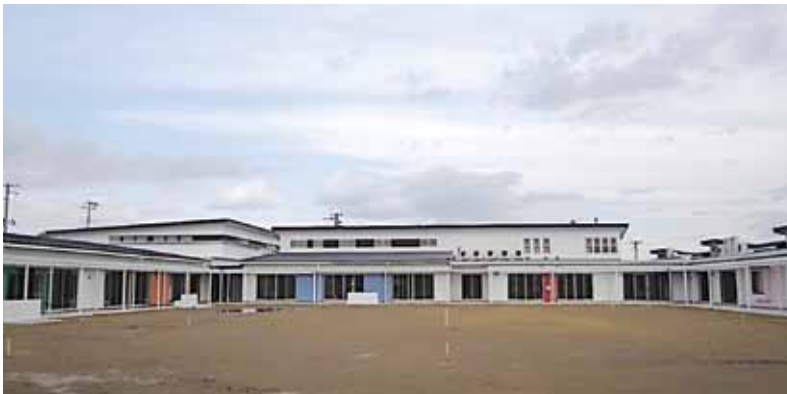
志波姫子育て支援センターが新設される志波姫幼保一体化施設
