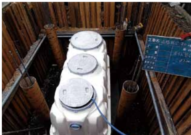
合併処理浄化槽設置工事の様子
