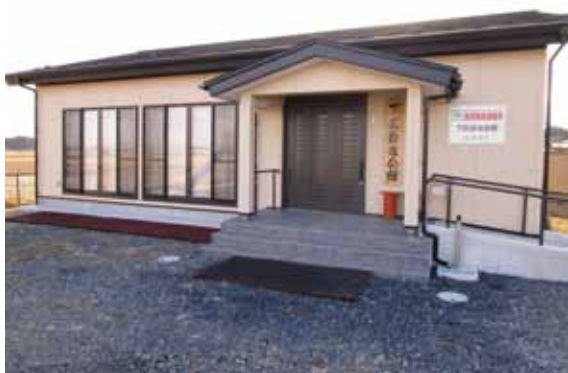
下区自治会館 (志波姫：平成25年度建設)
