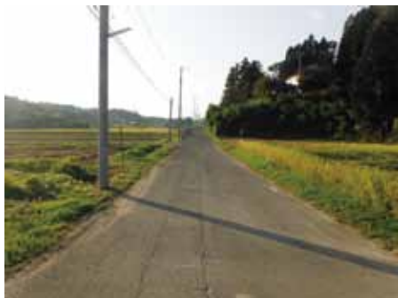
市道有賀沢種井戸線(施工前)
