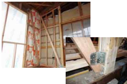
耐震改修の状況
