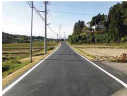
市道有賀沢種井戸線(施工後)
