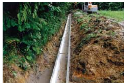
農業生産条件強化としての水路の整備
