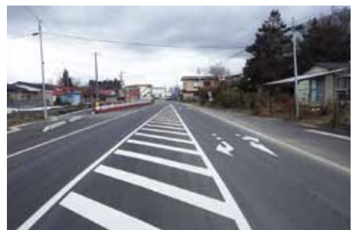
整備が進む都市計画道路一迫南線 (築館)
