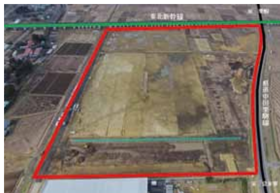
造成工事中の第2大林農工団地
