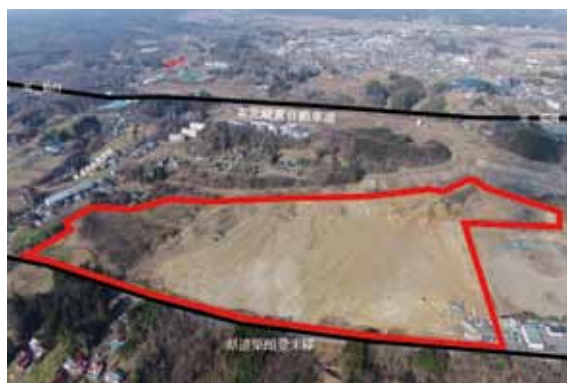
造成工事中の三峰工業団地
