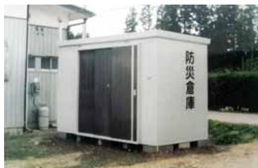
防災倉庫 一迫地区輝井自主防災組織
