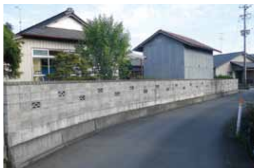
除却前のブロック塀
