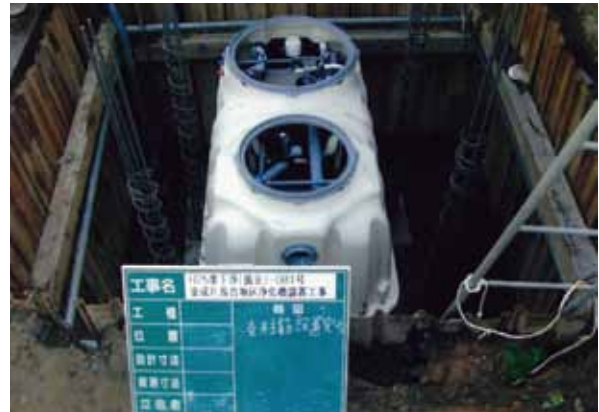
合併処理浄化槽設置工事の様子
