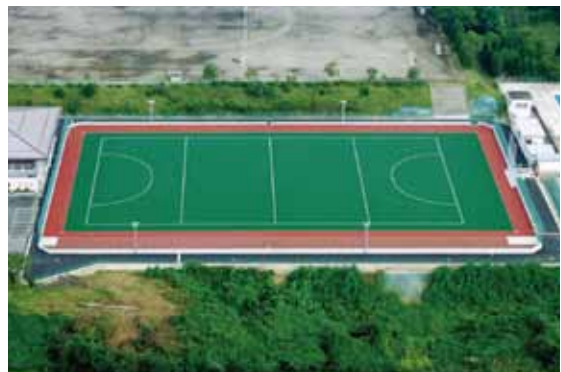
築館多目的競技場(平成12年竣工時)
