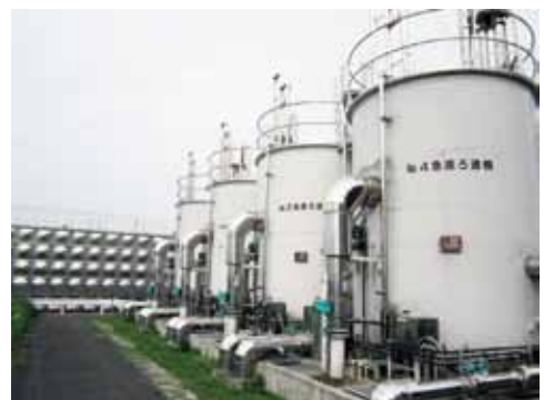
設置工事を予定している御駒堂浄水場
