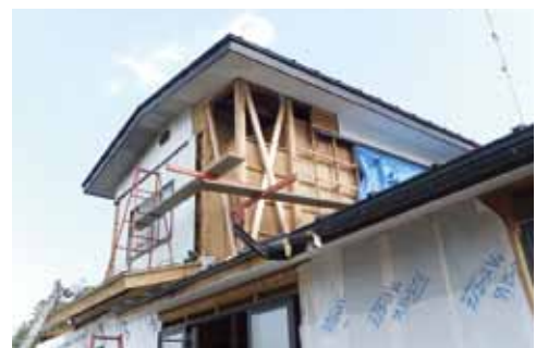
耐震改修の状況
