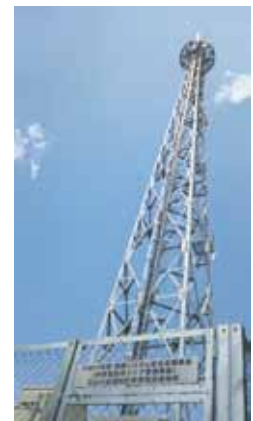
平成24年度に花山地区（小豆畑）に整備した鉄塔
