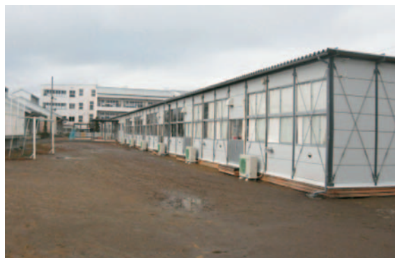
現在設置されている仮設のプレハブ校舎
