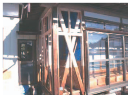
住宅耐震改修工事の状況
