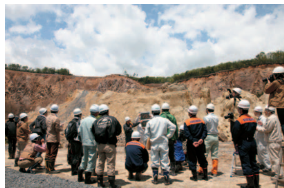
荒砥沢ダム崩落地の現地視察
