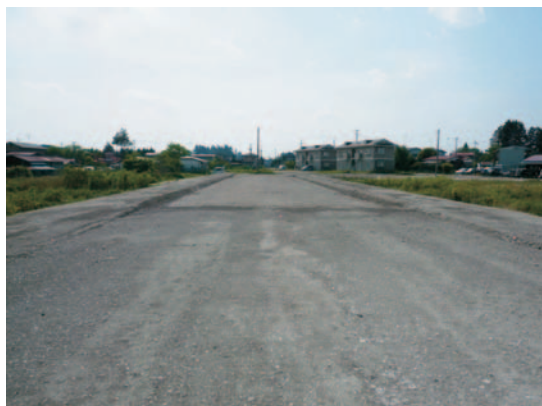
現在整備中の都市計画道路一迫南線
