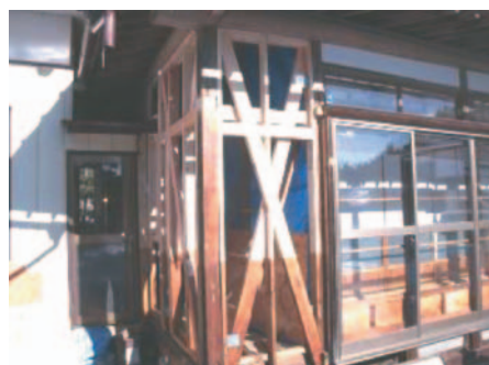
住宅耐震改修工事の状況
