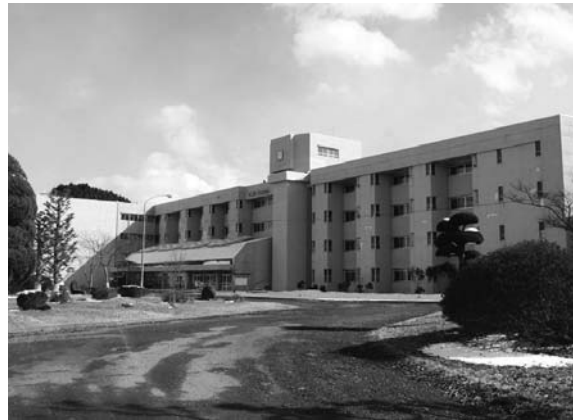
改修予定の栗駒中学校
