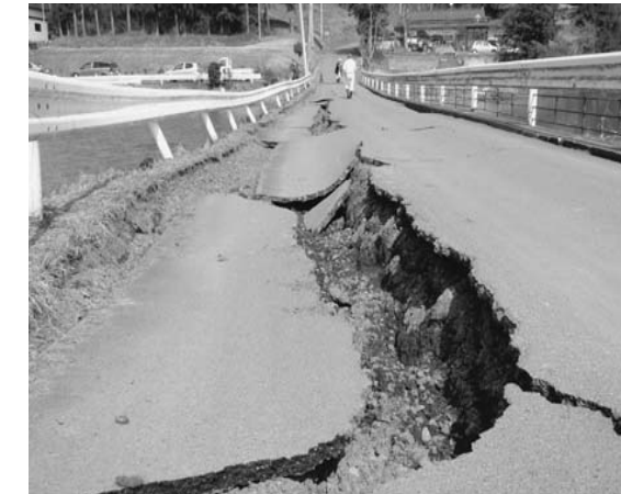
亀裂や段差などの被害を受けた市道陽岩寺線（瀬峰）
