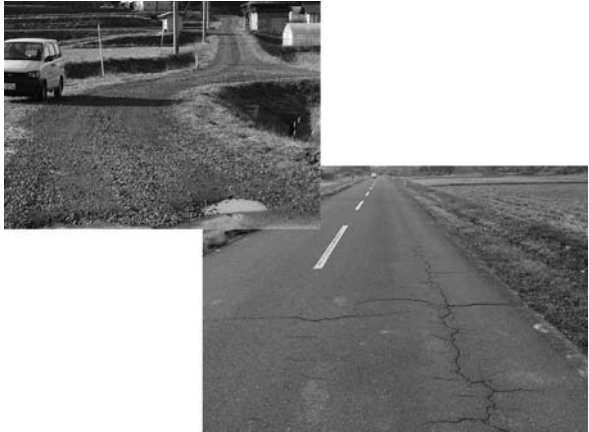
市道や農道の補修などを行います
