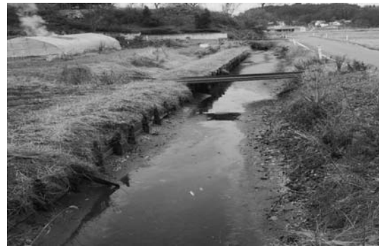
用排水路などの補修を行います
