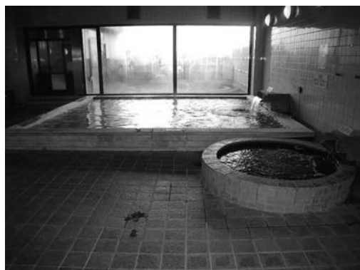
改修予定の金成延年閣大浴場
