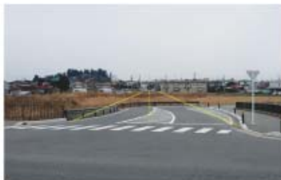
整備予定の都市計画道路一迫南線
