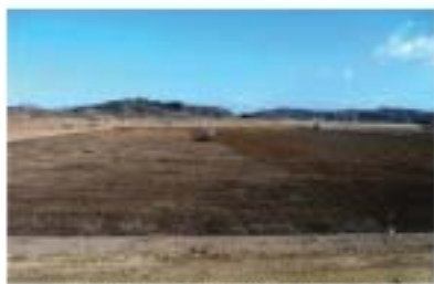
ほ場整備施工中の築館城下地区
