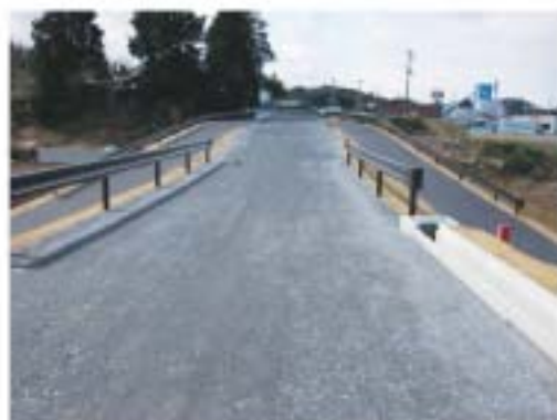
市道間渡戸線 (築館)
