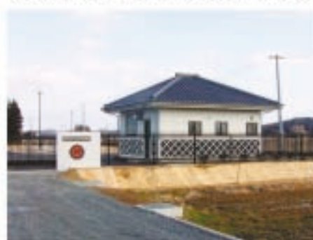
一迫高橋地区農業集落排水処理施設
