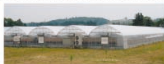
平成20年度に整備されたパイプハウス
