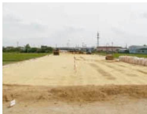
川北川南線道路整備の様子
