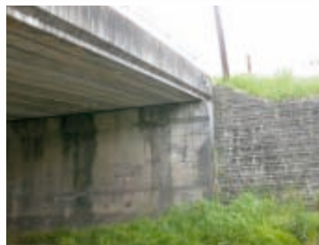
市道橋の一例
