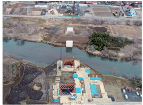
整備が進む大林線（仮称）栗原東大橋（若柳・志波姫地区）
