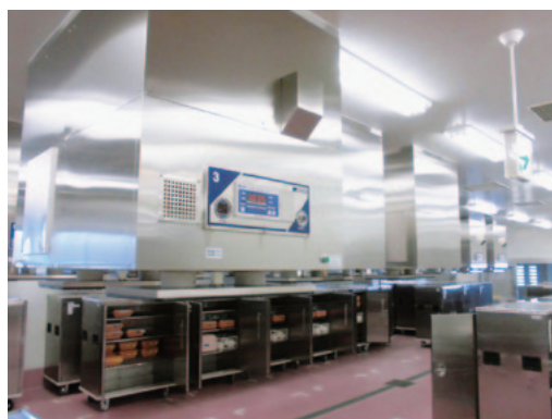
設備改修等を予定している南部学校給食センター
