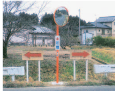
更新したカーブミラー
