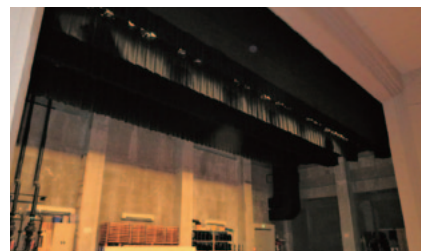
改修する大ホール舞台機構
