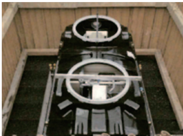
合併処理浄化槽設置工事の様子
