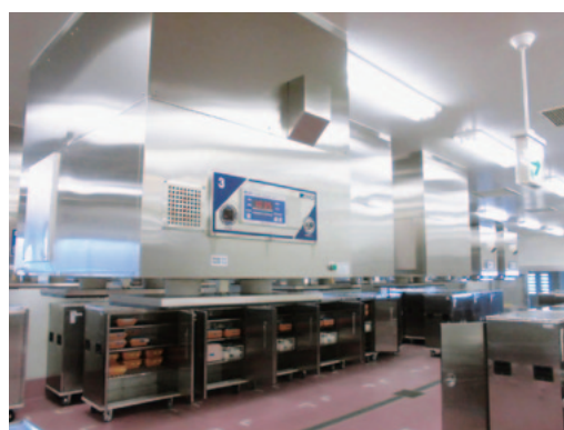
設備改修等を予定している南部学校給食センター
