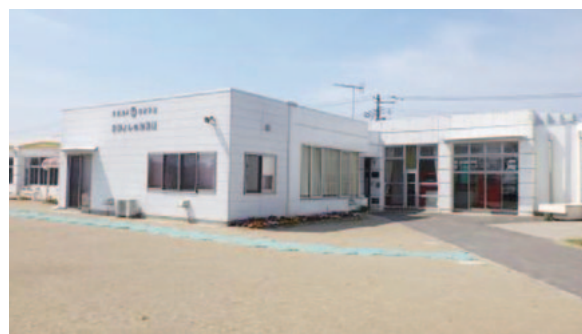
改修する旧若柳よしの幼稚園園舎
