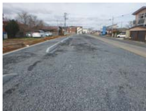
整備が進む一迫南線(築館地区)
