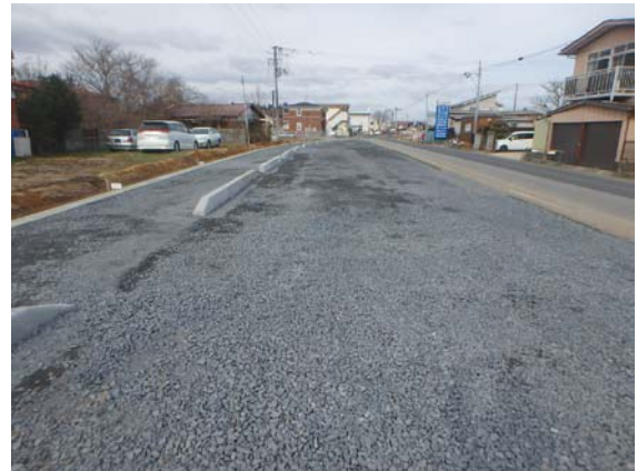
整備が進む一迫南線（築館地区）
