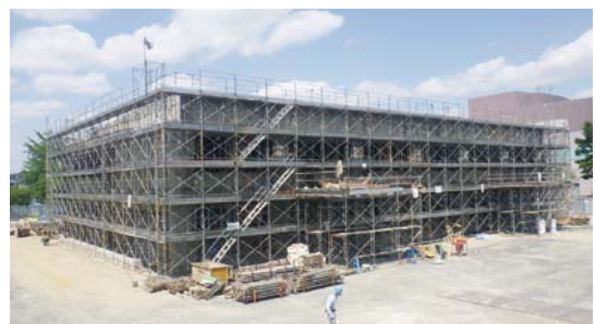
建設中の若柳公民館
