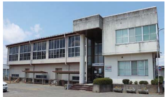
解体予定の志波姫体育センター
