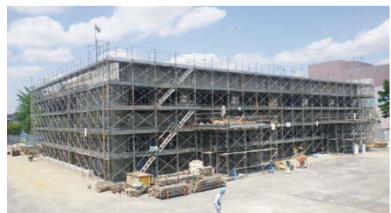
建設中の若柳公民館
