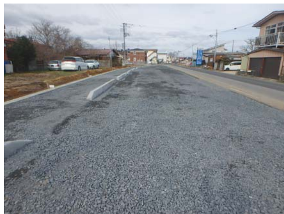
整備が進む一迫南線（築館地区）
