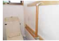
バリアフリー工事が行われた住宅
