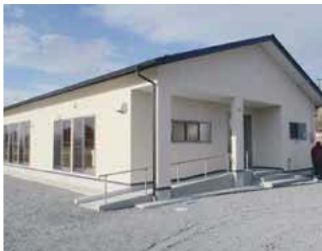
一迫保呂羽会館（改築）
