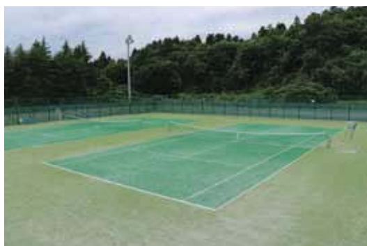
改修した栗駒テニスコート
