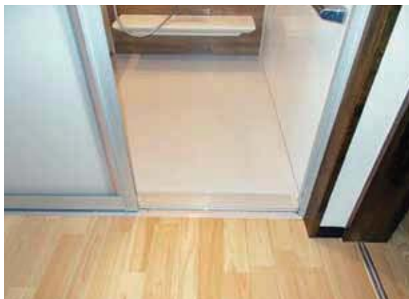
バリアフリー工事が行われた住宅
