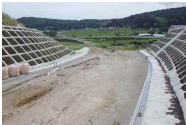
整備が進む清水目・嶋鉢線（一迫）
