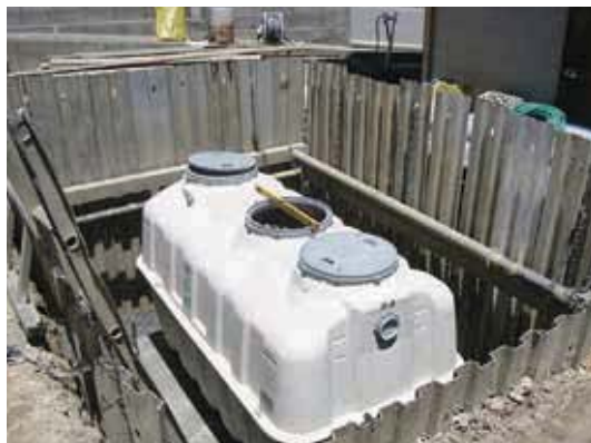
合併処理浄化槽設置工事の様子
