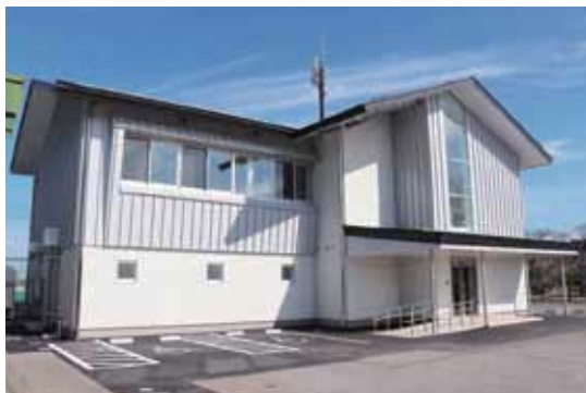
新設した管理棟
