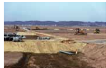
施工中の伊豆沼2工区地区
