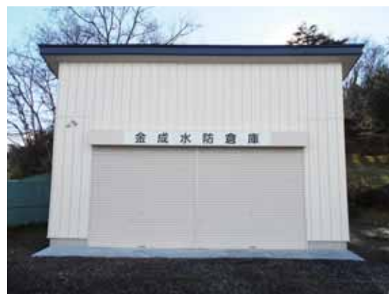
金成地区に新築した水防倉庫
