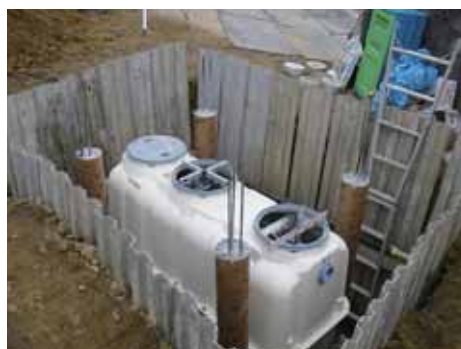
合併処理浄化槽設置工事の様子
