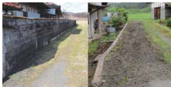
除却されたブロック塀
