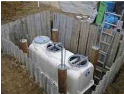
合併処理浄化槽設置工事の様子
