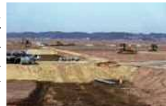
施工中の伊豆沼2工区地区
