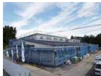
平成30年4月開園に向けて工事が進む瀬峰幼保一体施設
