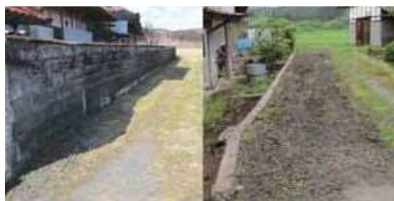
除却されたブロック塀
