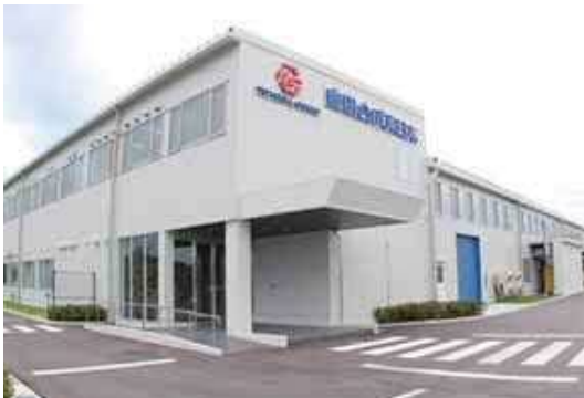
豊田合成東日本株式会社・宮城工場（高清水地区）
