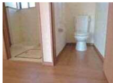
トイレのリフォーム工事 (バリアフリー化)
