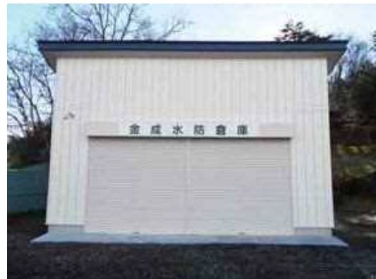
金成地区に新築した水防倉庫
