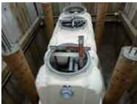
合併処理浄化槽設置工事の様子
