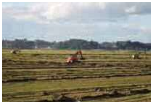
工事中の伊豆沼2工区地区（若柳）
