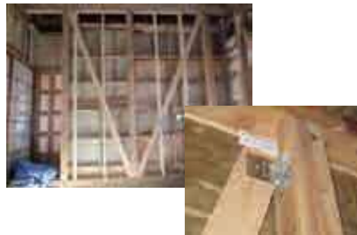
耐震改修の状況
