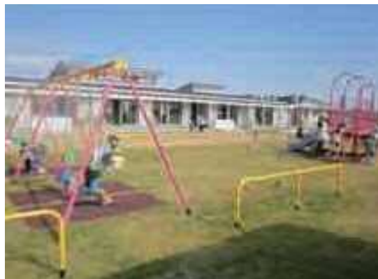
築館保育所の外観
