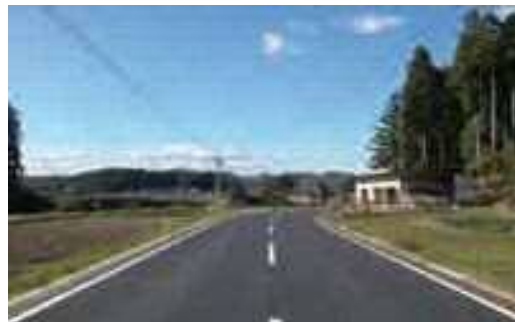
市道広域線(栗駒)修繕後
