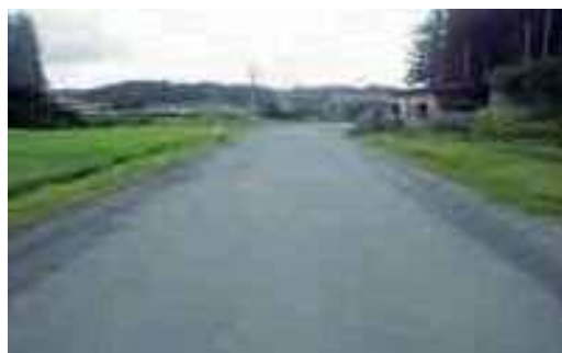
市道広域線(栗駒)修繕前
