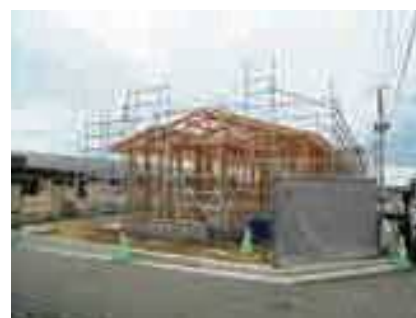
建設中の市営下山住宅(瀬峰)
