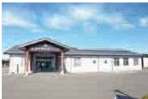
瀬峰総合支所に設置した太陽光発電設備
