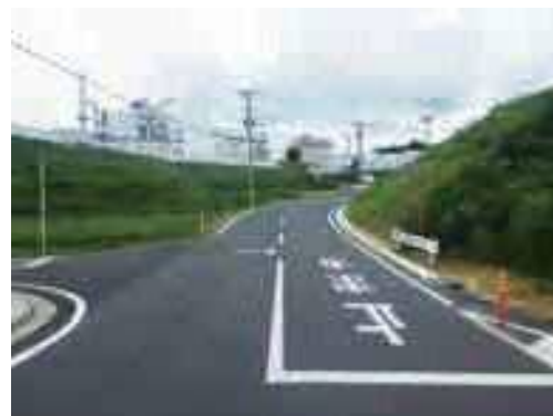
市道高森3号線(築館)
