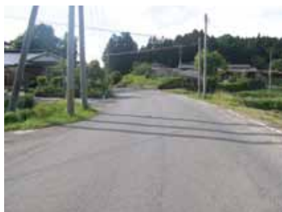
市道広域線(栗駒) 施工前
