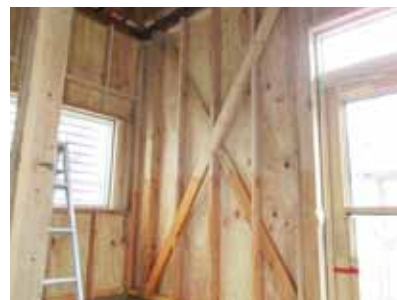
耐震改修工事の状況
