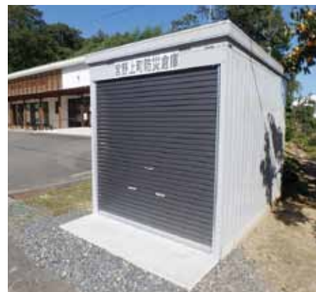
防災倉庫 築館地区宮野上町自主防災組織
