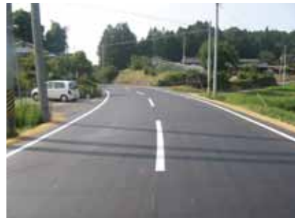
市道広域線(栗駒) 施工後
