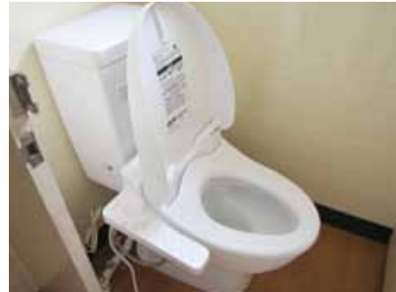
整備した温水洗浄便座
