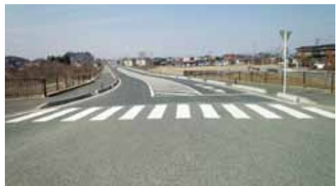
完成した都市計画道路一迫南線1期(築館)
