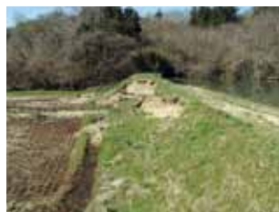
堤体が崩れた瀬峰葉沢西ため池
