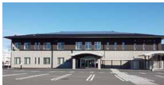
太陽光発電設備等を設置した築館総合支所
