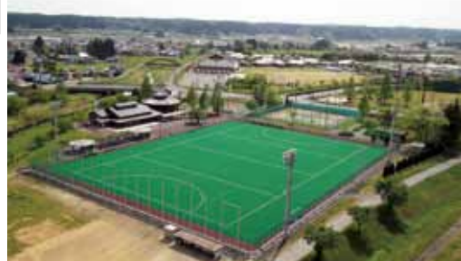
人工芝の張替えを行った一迫多目的広場
