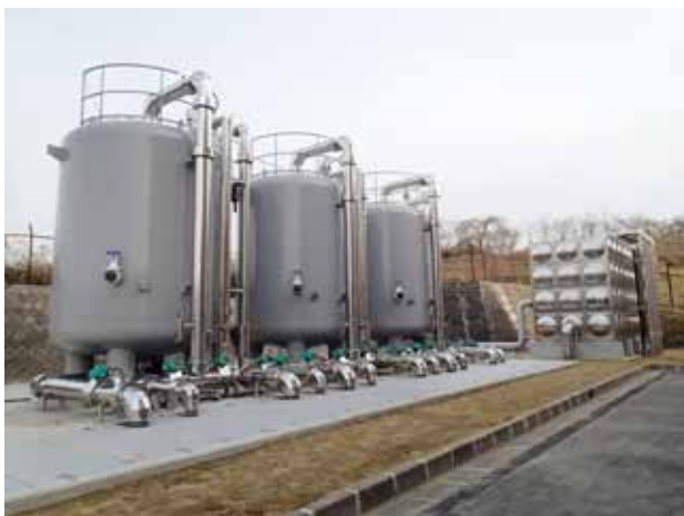
新田浄水場に設置した高度浄水処理施設
