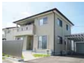
完成した栗駒病院 医師住宅1棟
