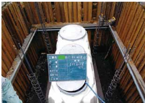
合併処理浄化槽設置工事の様子
