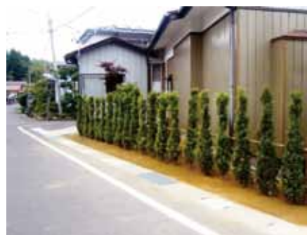
ブロック塀除却後
