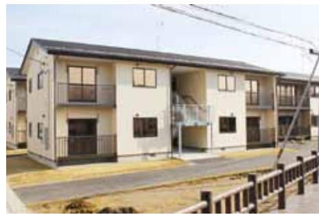
市営八日町住宅（市営上町裏住宅建替）
