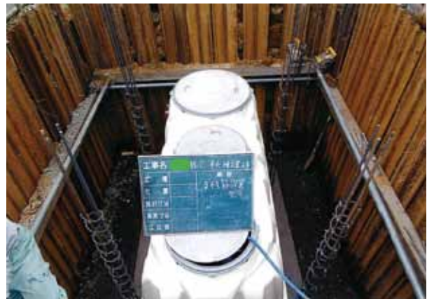
合併処理浄化槽設置工事の様子
