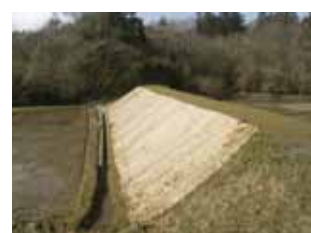
復旧後の瀬峰葉沢西ため池
