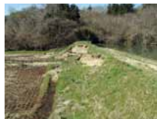
堤体が崩れた瀬峰葉沢西ため池
