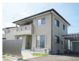
完成した栗駒病院 医師住宅1棟
