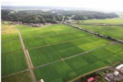
道路・用排水路・大区画のほ場が整備された沖富地区
