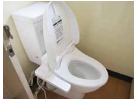
整備した温水洗浄便座
