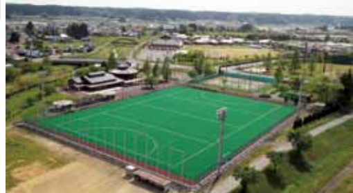
人工芝の張替えを行った一迫多目的広場
