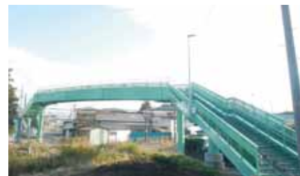
市道橋長寿命化対策 下田跨線橋 (瀬峰)
