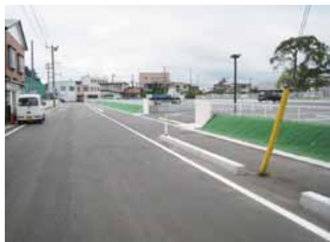
市道日吉通線(築館)
