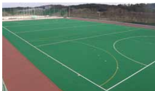
改修した築館多目的競技場
