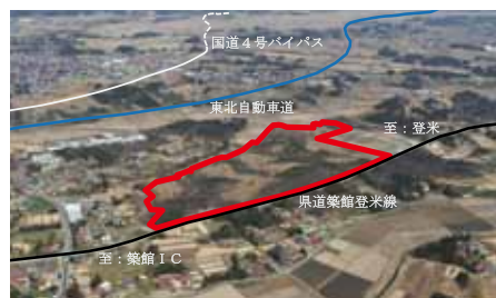
三峰工業団地 平成28年3月 完成予定
