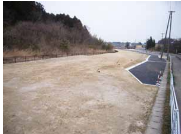
(仮称) 定住促進下藤沢住宅敷地 (造成)
