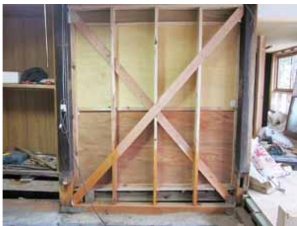
耐震改修の状況
