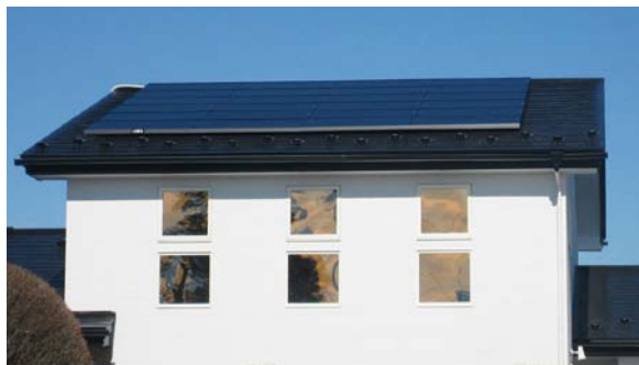
一般家庭への普及が進む太陽光発電パネル
