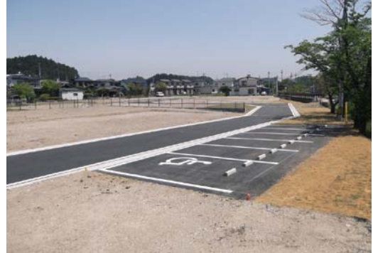
市営八日町住宅建設地 (上町裏住宅建替)
