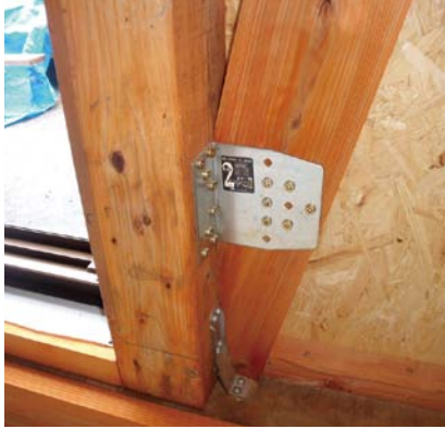
住宅耐震改修の状況
