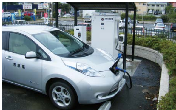
栗原市役所駐車場に設置した急速充電器(平成25年10月完成)
