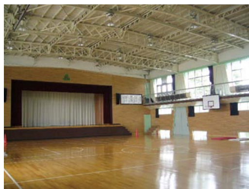
改修された鶯沢小学校体育館の様子
