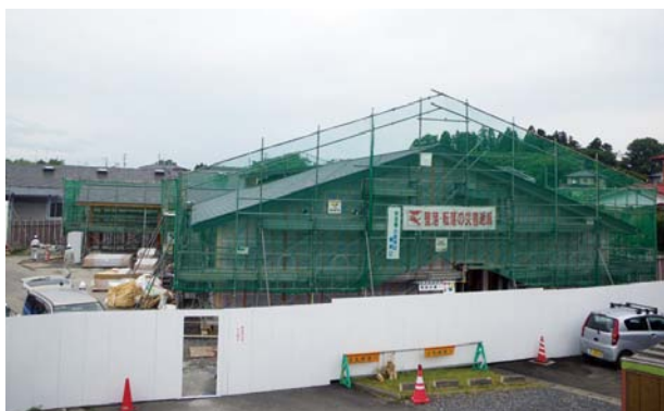
新築工事を進めている瀬峰総合支所
