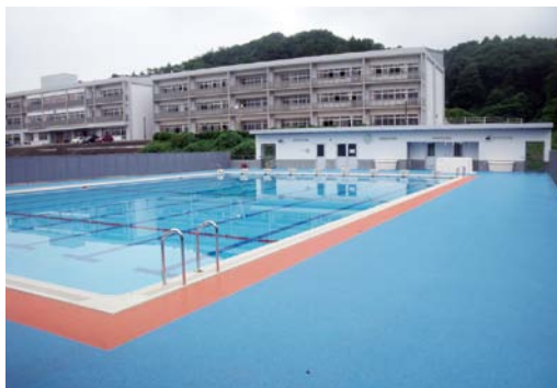
完成した築館中学校プール
