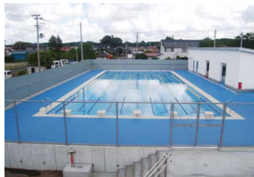
完成した高清水中学校プール
