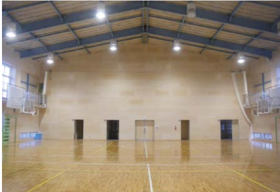
完成した志波姫小学校体育館の様子
