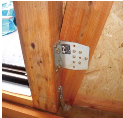
住宅耐震改修の状況
