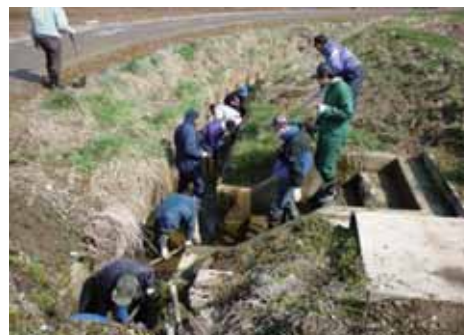
共同活動による水路の泥上げの様子
