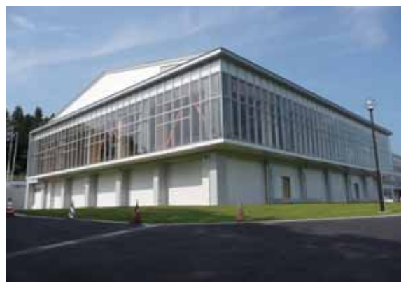
完成した築館中学校体育館
