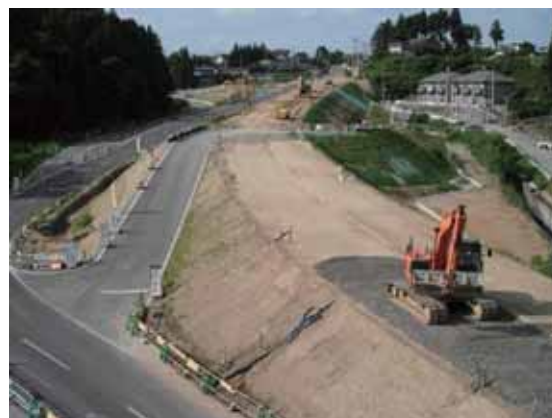
整備中の都市計画道路源光町田線
