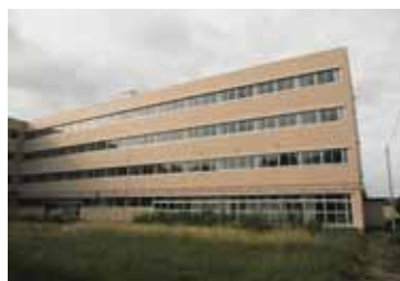
改修後の栗駒中学校校舎
