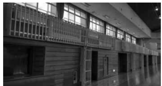
設置改修工事中の若柳総合体育館
