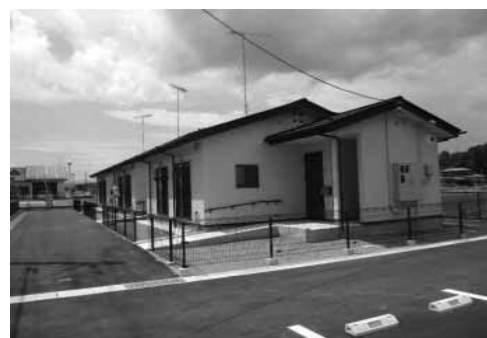
屋外整備工事を行った北河原住宅
