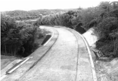
駅前大通線（築館） 中間から終点を望む
