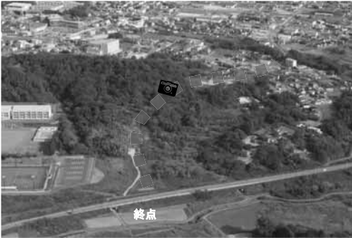
駅前大通線（築館） 全景
