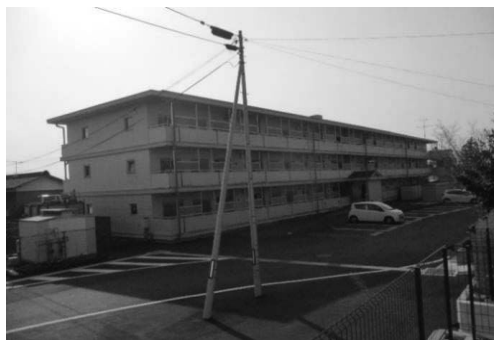
外壁補修等の改修設計を行った五輪東住宅A棟（外観）
