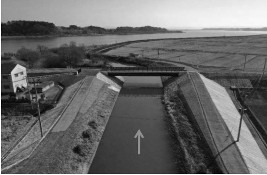
市道横須賀上畑岡線（築館）
