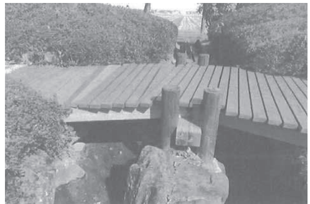
修繕した公園の橋
