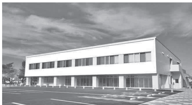
完成した若柳公民館
