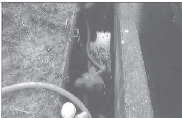
伊豆野都市下水路汚泥浚渫業務（築館）
