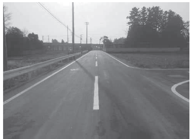
市道花崎線舗装打換工事 【施工後】
