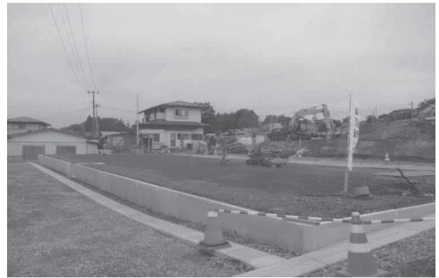
造成中の五輪東住宅建設地（高清水）
