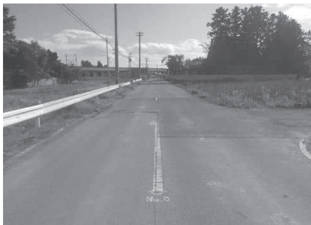
市道花崎線舗装打換工事 【施工前】
