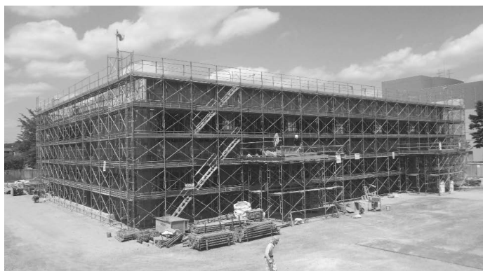
建設中の若柳公民館
