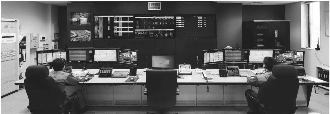
更新された高機能消防指令センター指令装置と表示盤
