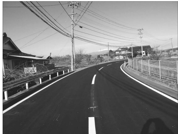
市道桜田菱沼線舗装修繕工事 【施工後】
