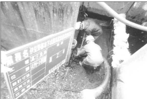
伊豆野都市下水路汚泥浚渫業務（築館）
