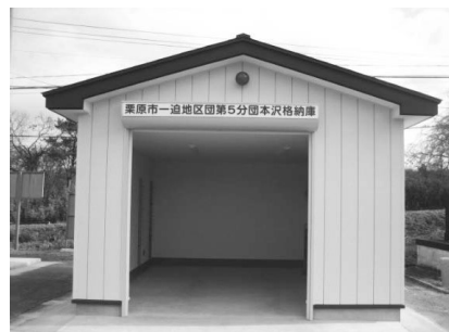
消防ポンプ車格納庫(一迫)
