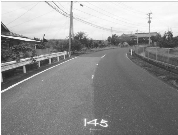
市道桜田菱沼線舗装修繕工事 【施工前】
