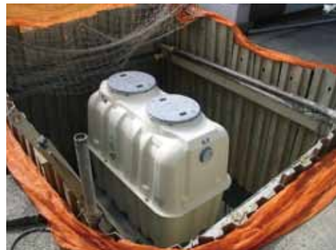
合併処理浄化槽設置工事の様子
