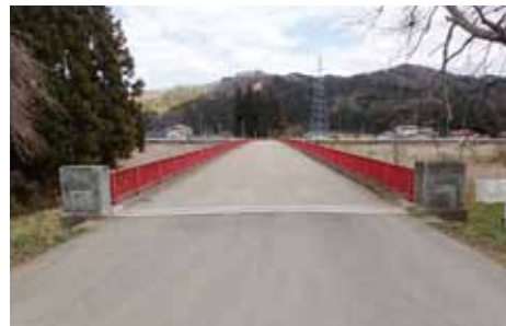
補修した御駒橋（市道馬場駒の湯線 栗駒地区）
