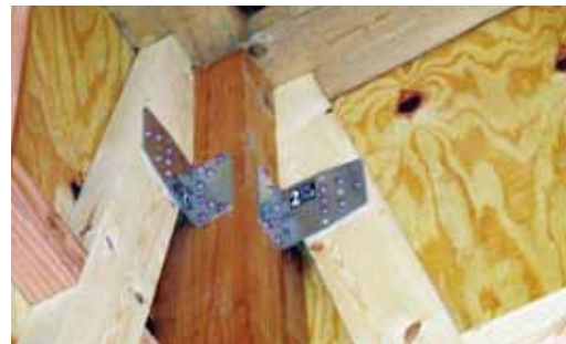
耐震改修した柱
