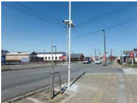
設置した防犯カメラ
