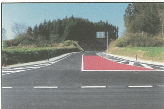
【道路起点から撮影】
